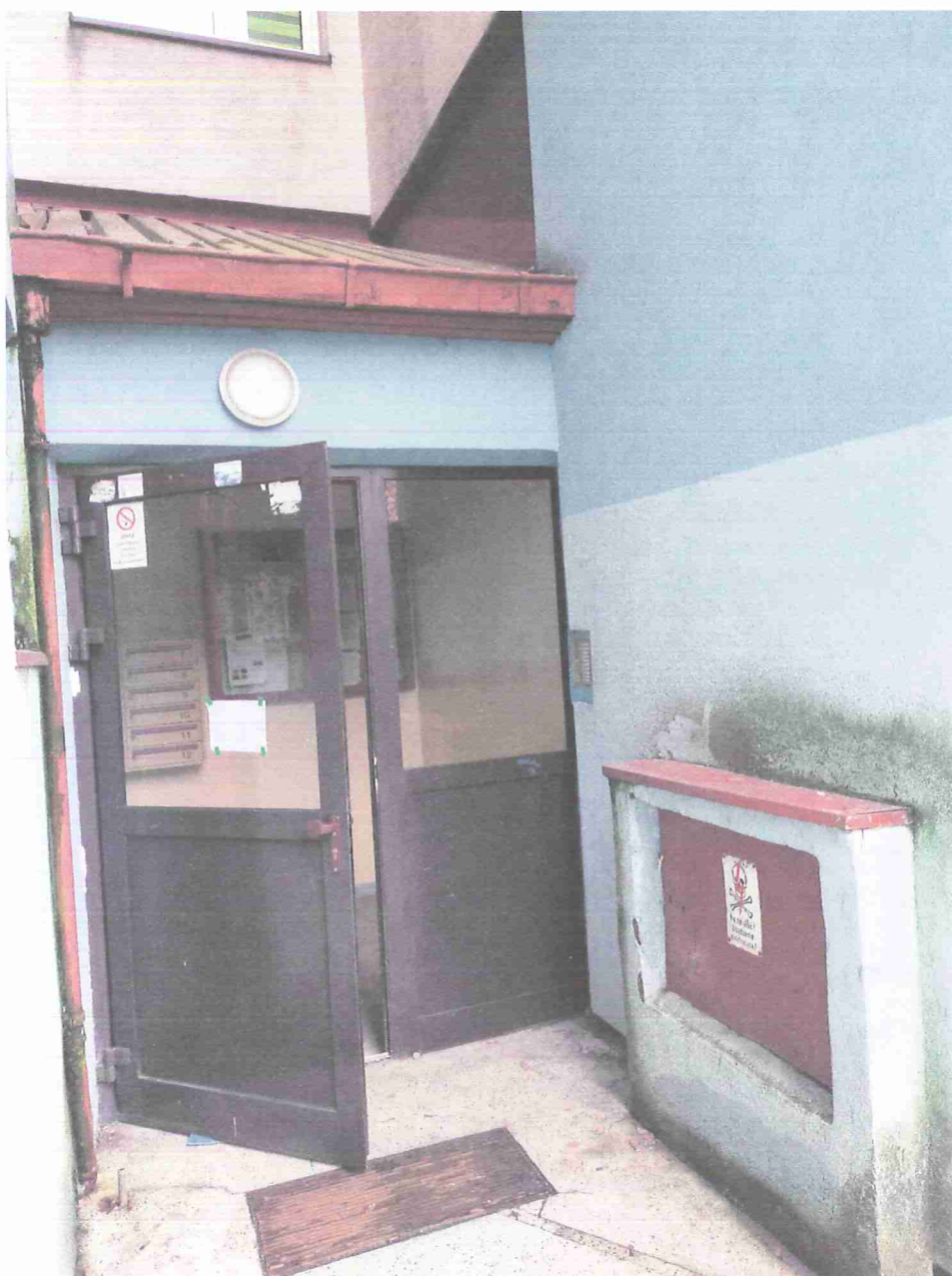
Widok istniejącego zadaszenia
