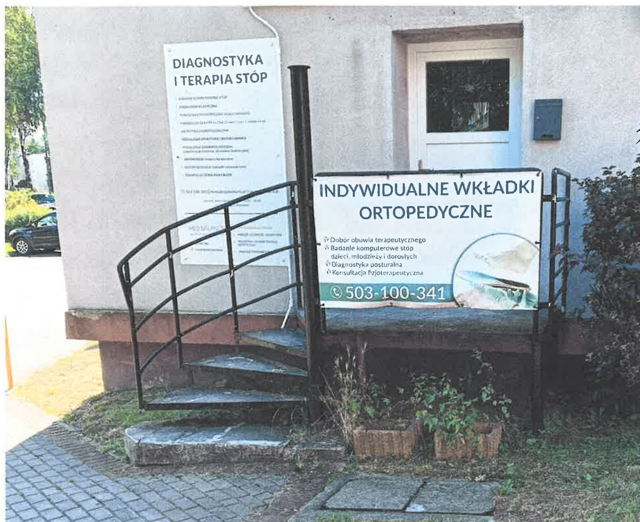
Widok istniejących schodów
