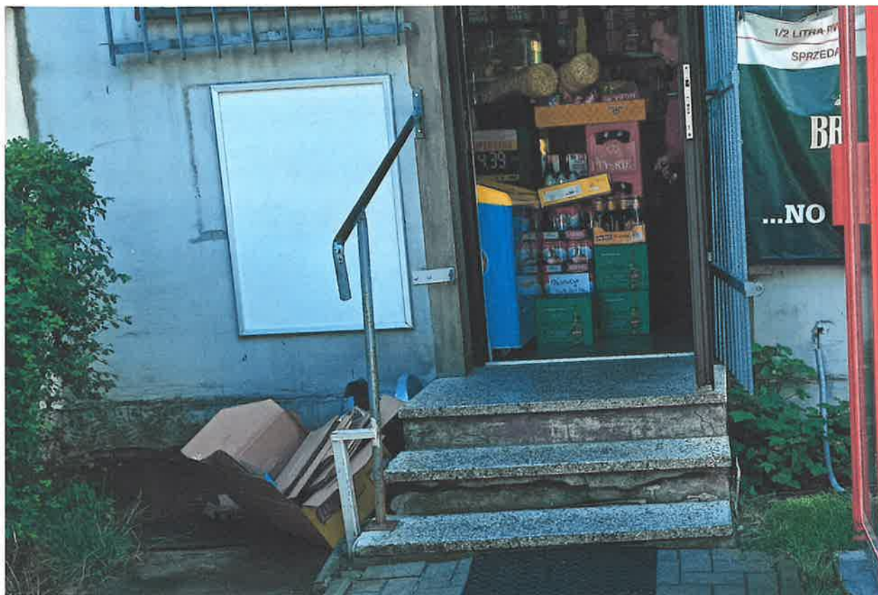
Widok istniejących schodów
